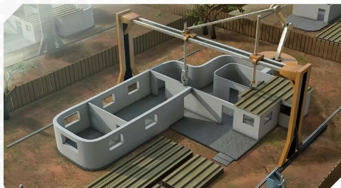
شکل ۳: مدلی از ساخت‌وساز به روش ساخت پیرامونی
