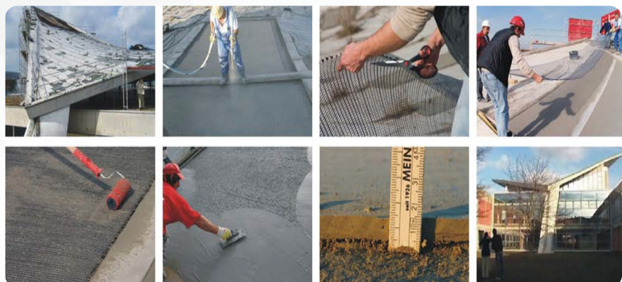
شکل ۹: تقویت پوسته هایپر در شواینفورت
