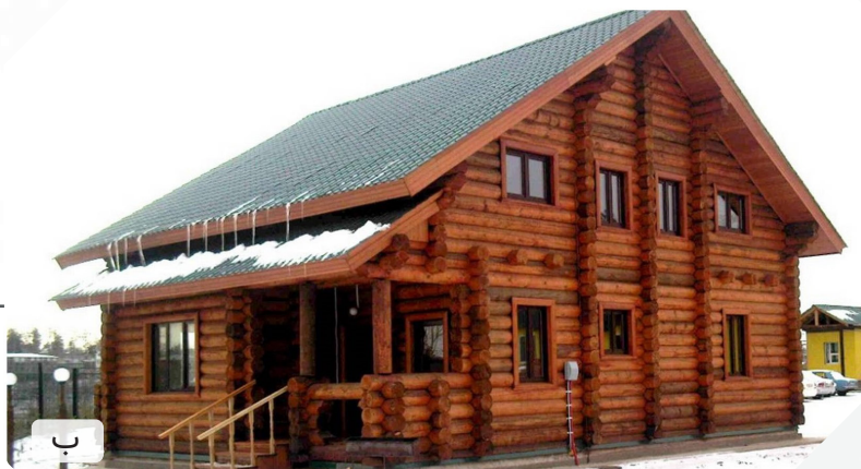
ب) ساختمان سیستم ترونکو که جهت متشابه شدن با الوارهای چوب رنگ آمیزی شده است.
