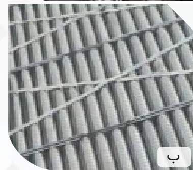
شکل ۵: اجرای مهاربندهای تسمه‌ای به صورت ضربدری بر روی الف) بر روی پوشش دیوار، ب) بر روی پوشش سقف
