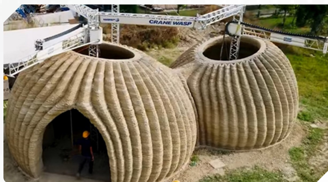
شکل ۴: سازه پرینت شده به روش ساخت پیرامونی دوست‌دار محیط‌زیست در کشور ایتالیا
