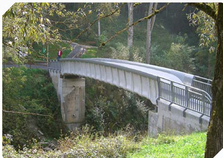
شکل ۵: پل ساخته شده با روش TRC با دهانه شانزده متر در شهر کمپتن، آلمان [۸]
