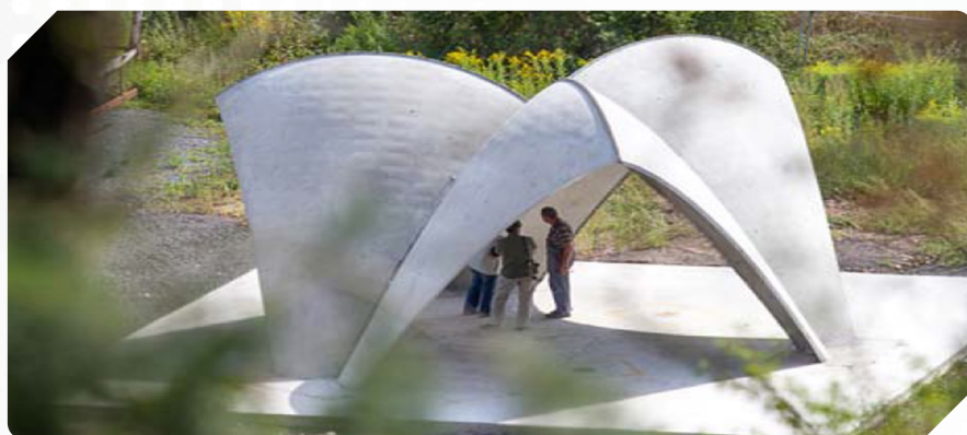
شکل ۷: ساختار غرفه ساخته‌شده از شش المان بتنی TRC [۱۲]
