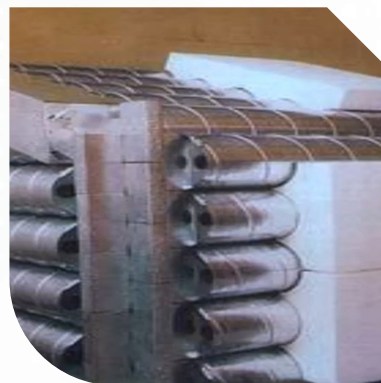
شکل ۷: عایق حرارتی اجرا شده بر روی لوله‌های گالوانیزه به صورت قطعه پازل
