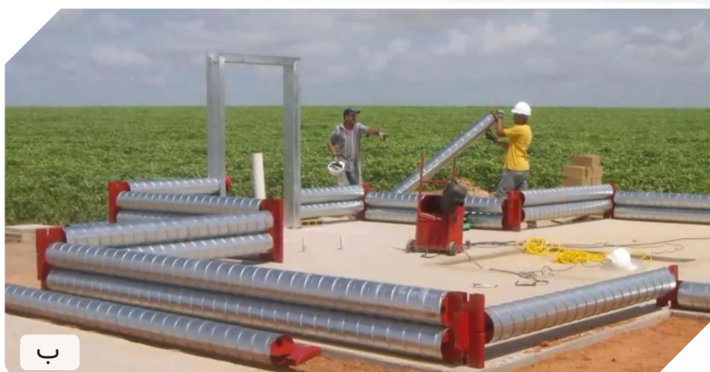
شکل ۶: نحوه اجرای سیستم ترونکو
