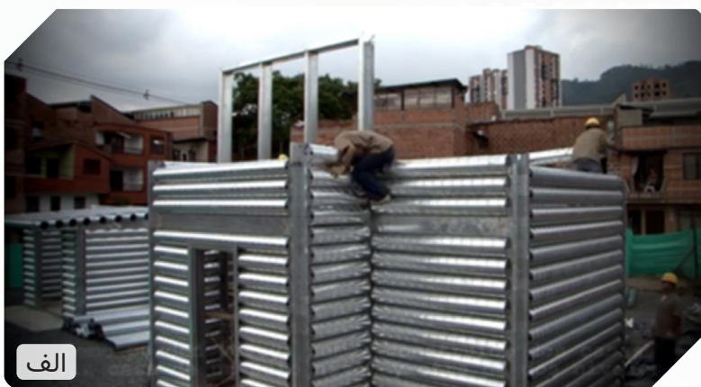
شکل ۱: الف) سازه در حال اجرای سیستم ترونکو
