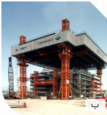
شکل ۱: الف و ب) سیستم ساخت و ساز اتوماتیک شرکت اوباشی
